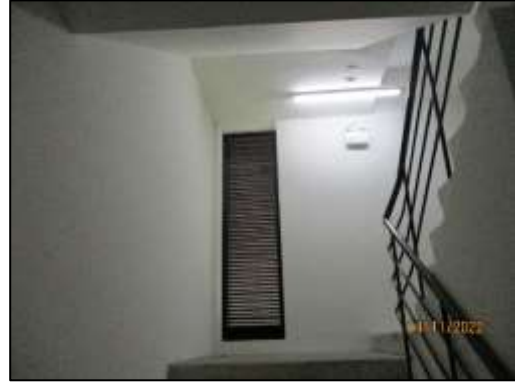
รูปที่ 1-8 บันไดหนี และระบบระบายอากาศของบันไดหนีไฟ
