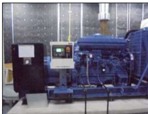
รูปที่ 1-7 เครื่องกำเนิดไฟฟ้า
